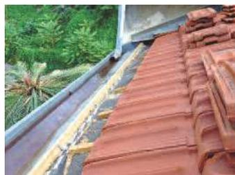
Une évacuation extérieure n'avait pas pu être installée, du fait du voisinage. Ce problème technique devait être corrigé au plus vite. Une entreprise spécialisée proposa de recouvrir le chéneau de tuiles et d'ajouter une gouttière sur le mur droit avec une évacuation sur l'arrière de la villa. Début novembre, sous l'œil avisé de Serge Masotti, l'entreprise réalisa les travaux très rapidement et put ainsi mettre la villa Marie-Ange définitivement à l'abri de toute nouvelle intempérie.
