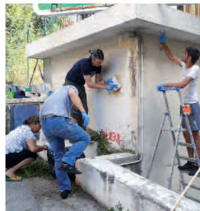
Le principe de payer en fin de matinée des publics usagers de drogue qui ont remis en état pendant trois heures (petite maçonnerie, peinture) des transformateurs Edf, encadrés par une équipe mixte d'éducateurs de l'Aava (Atelier d'adaptation à la vie active) et du Caarud (Centre d'accueil et d'accompagnement à la réduction des risques des usagers de drogue) est un succès !
