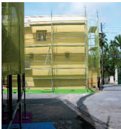
Suivi des travaux des façades du siège social Casa Vecchia
