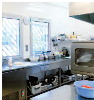
Mise en conformité de la cuisine de La Maison de l'enfance de La Trinité
